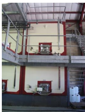
Cuve en béton tapissée de céramique
